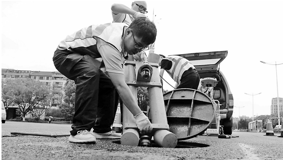
工作人员在对排水主干管网进行“体检”。
