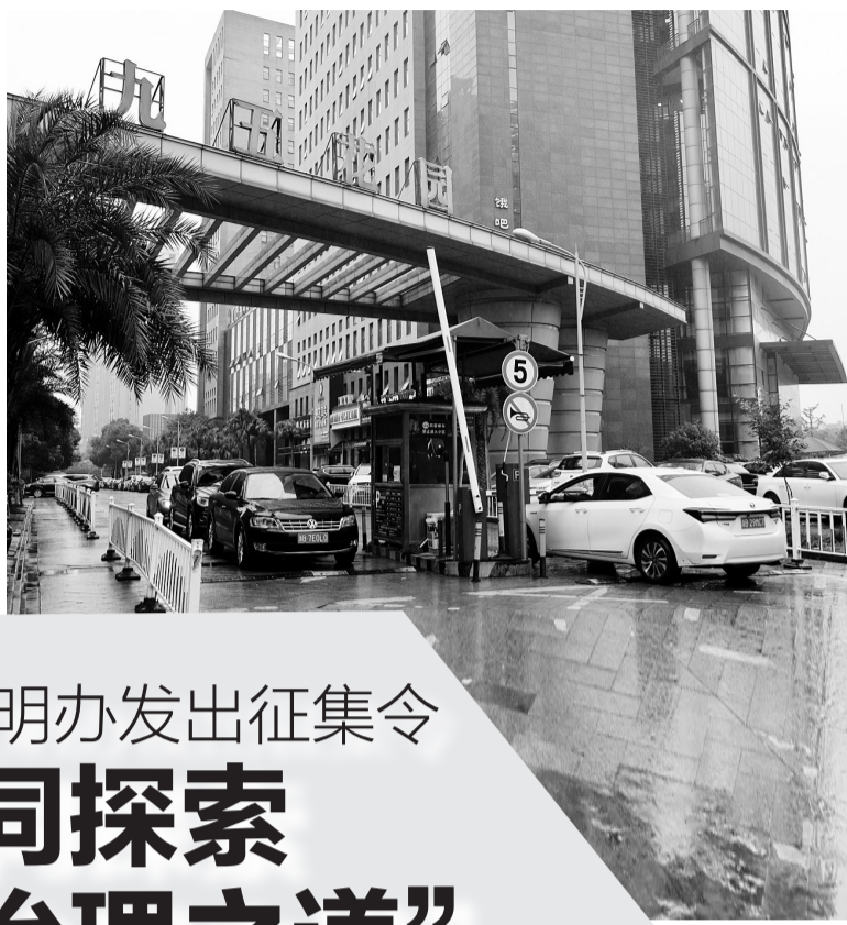
高新区九五花园安装道闸后,车辆进出有序。
