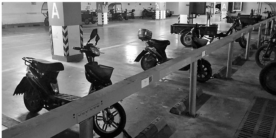
路林市场在地下车库开辟了集中充电桩。
