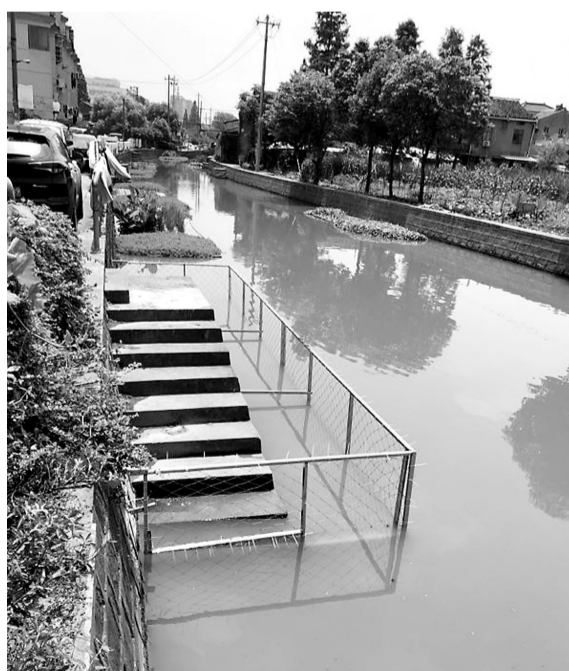
海曙古林镇的部分河埠头已安装了护栏。
