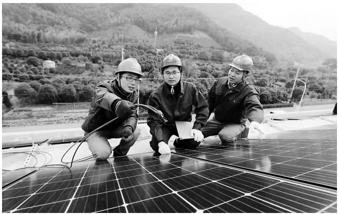
糜海挺(中)和同事们在大路村检查光伏发电设备。 通讯员 朱珊珊 摄
