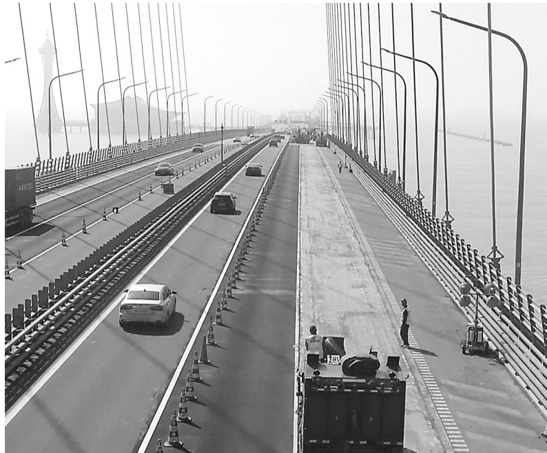
今年4月路宝新材料在杭州湾跨海大桥南航道桥钢桥面铺装更换完成。 受访者供图
