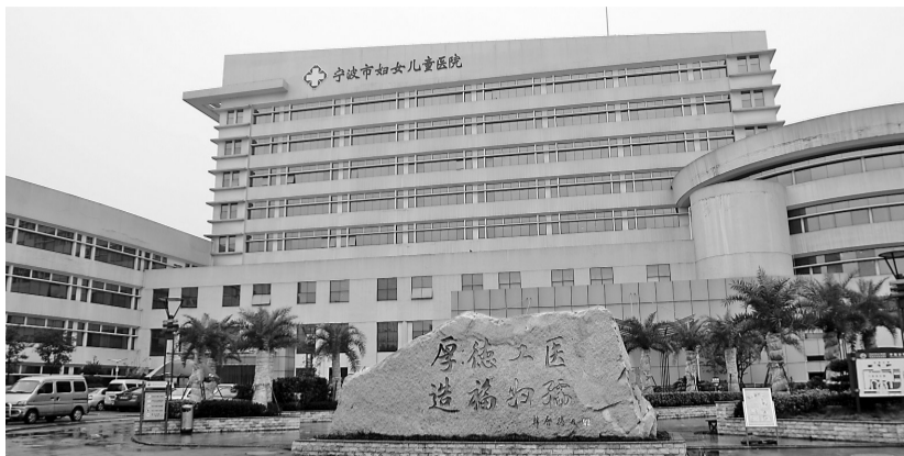
宁波市妇女儿童医院南院门诊楼
