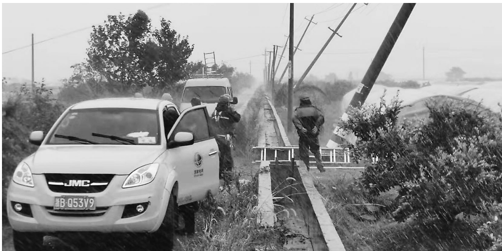
昨天,象山电力工人抢修电线杆。 通讯员 史仲夷 供图
