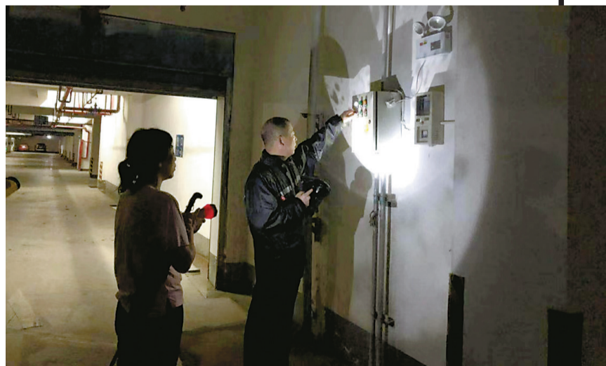
赵剑军和社区工作人员在检查小区地下车库的排水设施。
