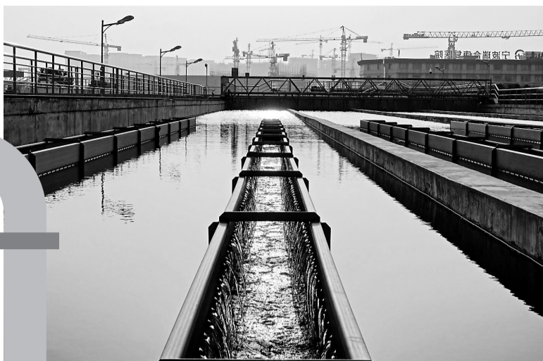
夕阳下的姚江工业水厂沉淀池。
