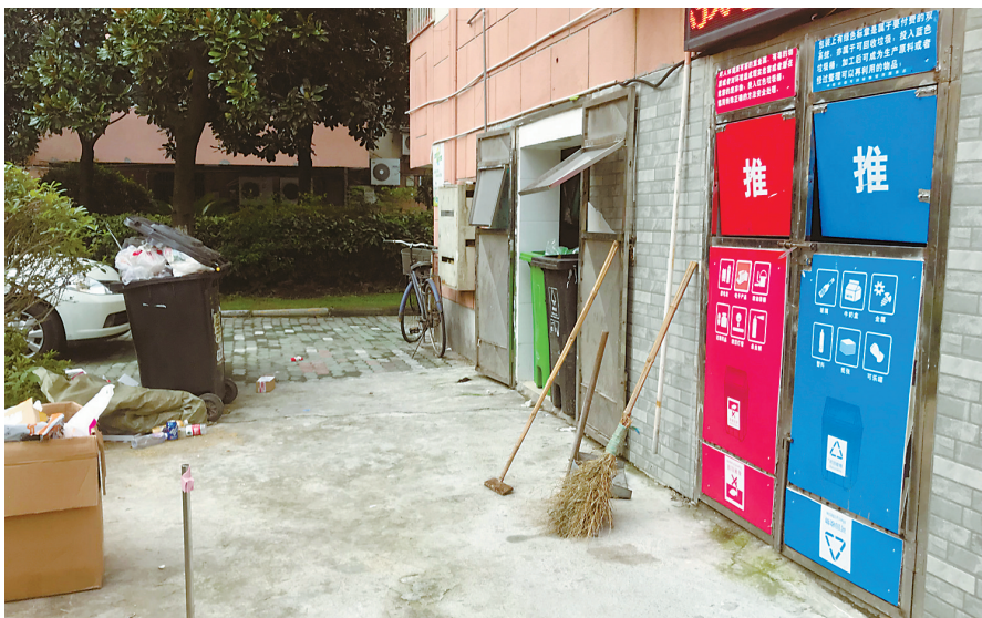
生活新境小区现在的垃圾房太小,导致工具裸露在外。
