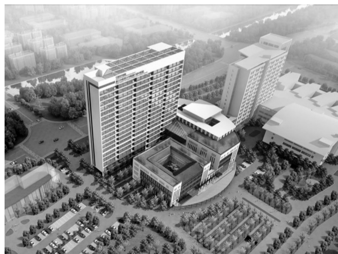
宁波市中医院扩建项目将于2019年年底竣工。
