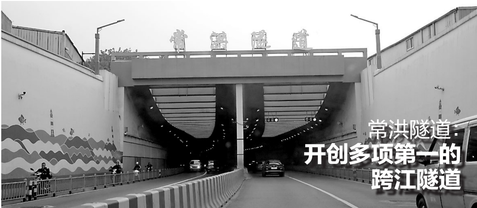
常洪隧道 记者 张培坚 摄
