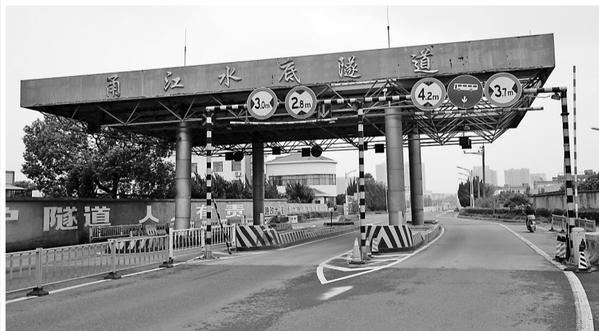
甬江水底隧道。 记者 张培坚 摄
