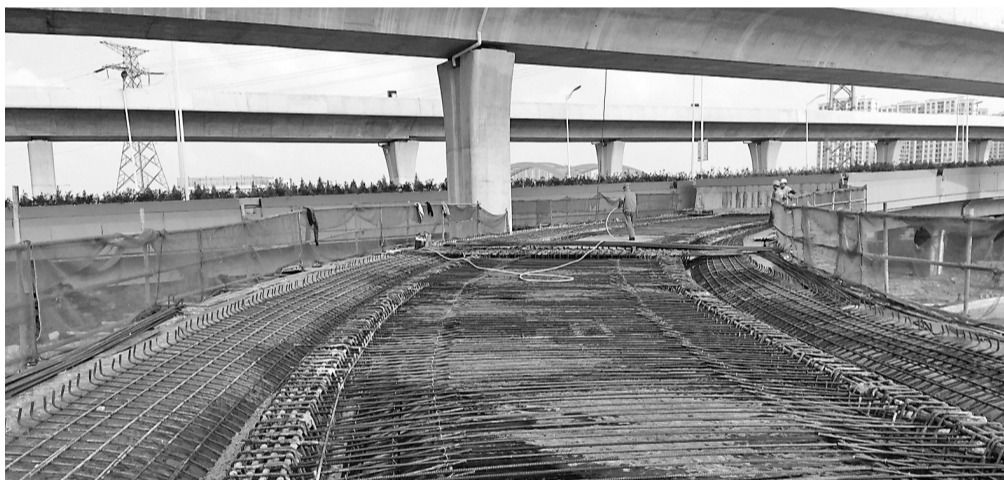
施工现场。鄞城集团供图
