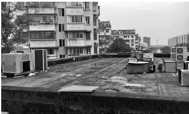
洪塘中路姚江花园东侧餐饮一条街的烟道正在拆除。 洪塘街道宣传办供图
