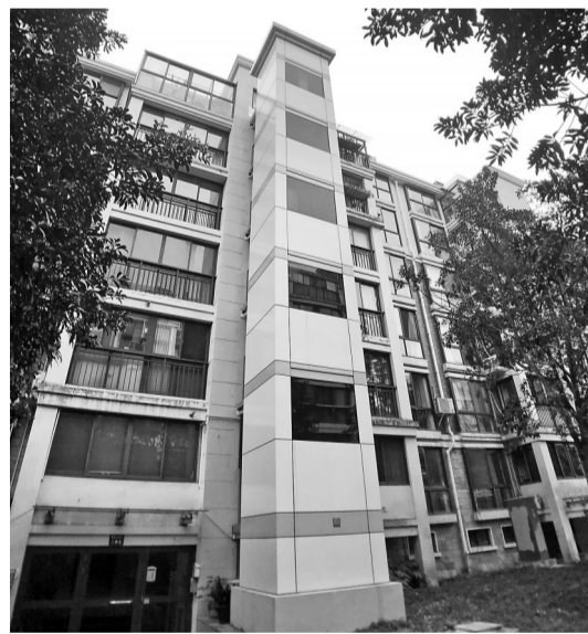
清泉花园小区已经投入使用的电梯。
