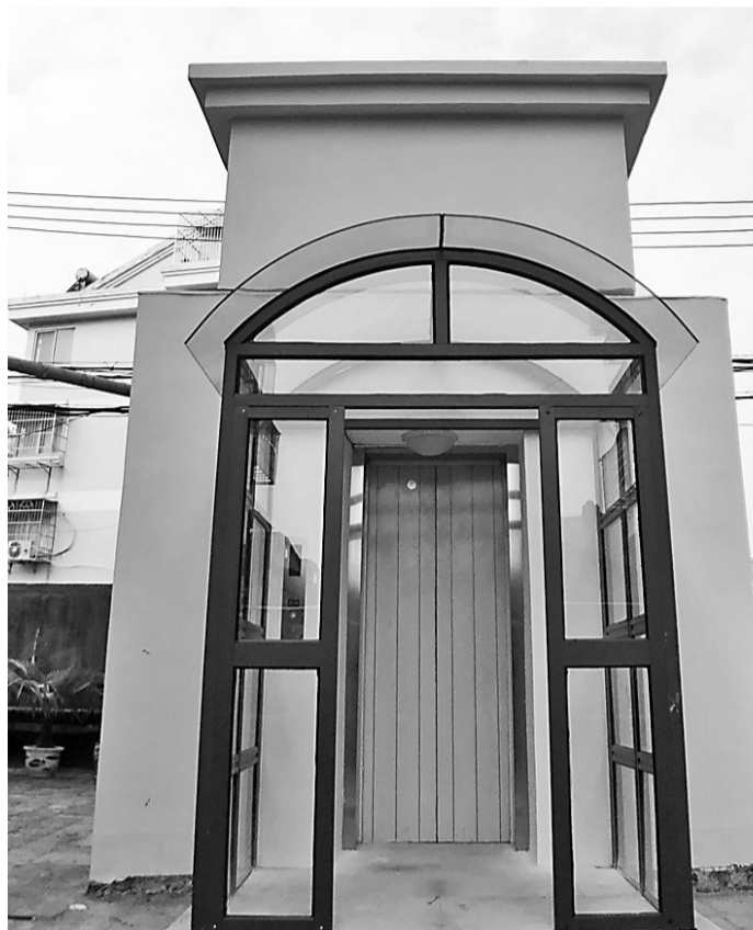
镇海招宝山街道总浦桥社区童李衙弄，垃圾竖井改造而成的电梯即将投入使用。
