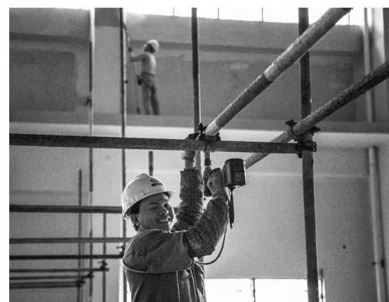
桃源水厂施工现场。吴艳 摄
