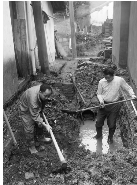
上叶家社区农村污水改造二期项目在施工中。
