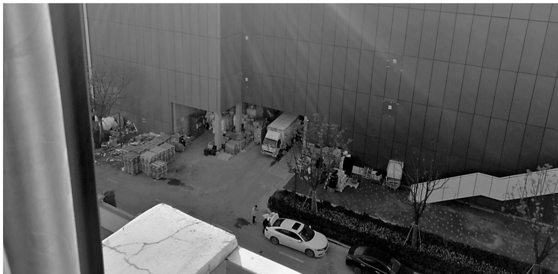
小区居民楼下的空地是广场的卸货区和垃圾堆放区。
