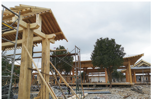
《青簪行》剧组正在制景。通讯员供图
