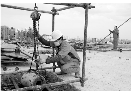
现场施工人员正在忙碌。 记者 杨辉 摄
