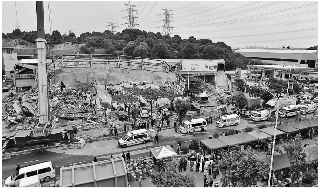
3月8日拍摄的泉州欣佳酒店坍塌事故救援现场。新华社发
