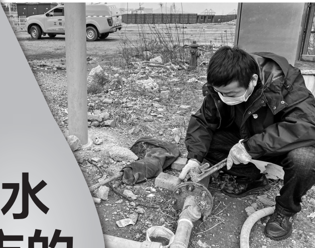
许一波在隔离区安装供水管道。
