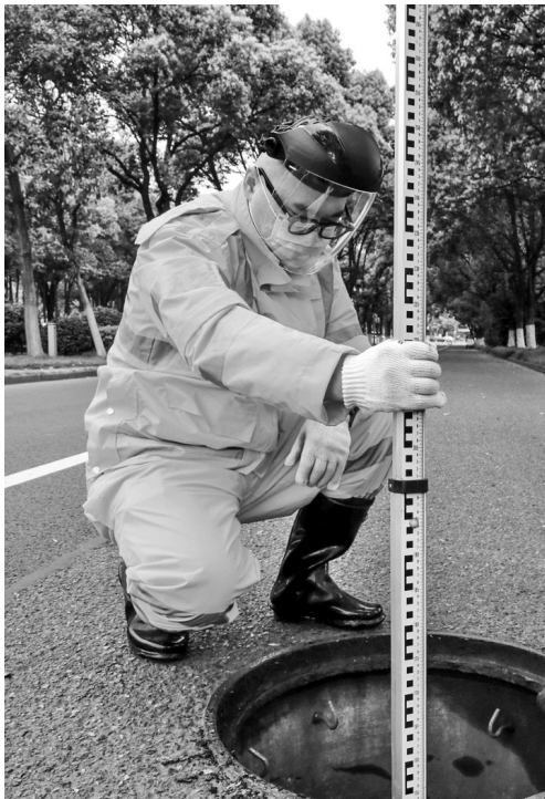
毛剑升在测量地下管网液位。
