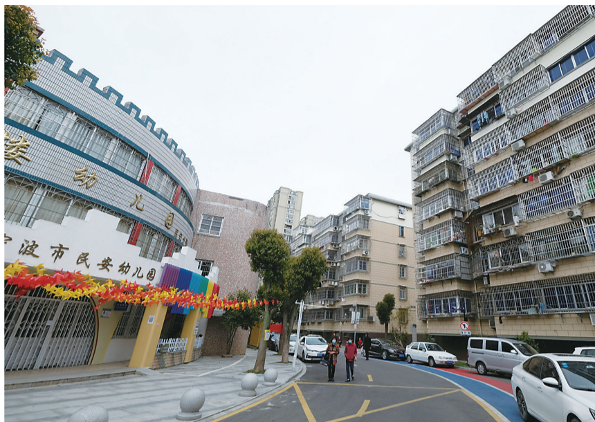
“脱胎换骨”后的民安小区。
