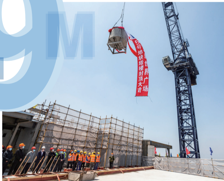
▶主体结构封顶
