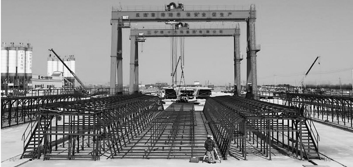
杭甬复线宁波段一期正在抓紧施工。
