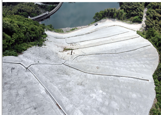
余姚梨洲街道燕窝-黄明-梁辉乡道一处地质灾害点(治理后)。
