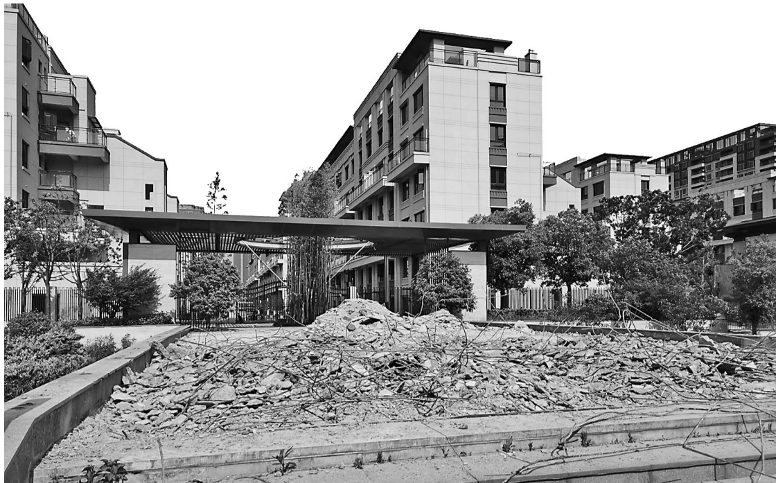
绿地观堂花苑小区东门外的这座桥,已经被拆了一半。
