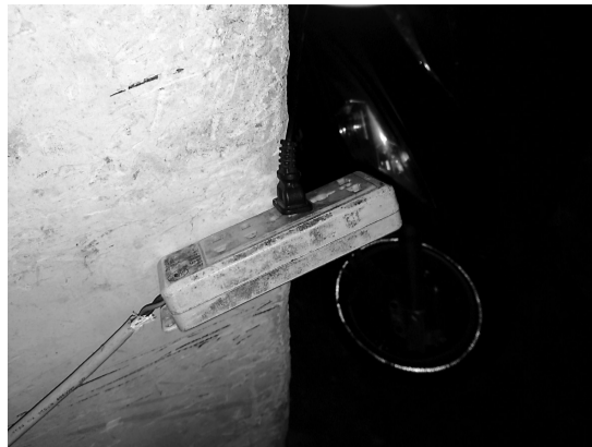
涨鑑碛小区，“睦邻楼”一楼楼梯间过道，有人私拉电线，给电动自行车充电。
