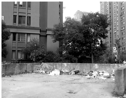
锦绣曙光小区，两处建筑垃圾堆放处，未清理干净。
