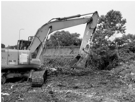
昨日下午，现场已完成垃圾清理和土地平整。
