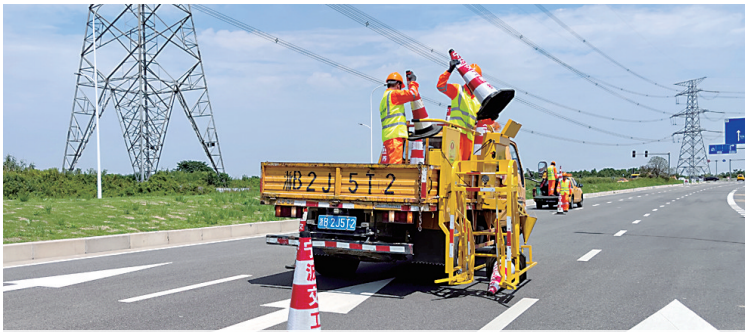
“黑科技”装备亮相杭州湾跨海大桥
