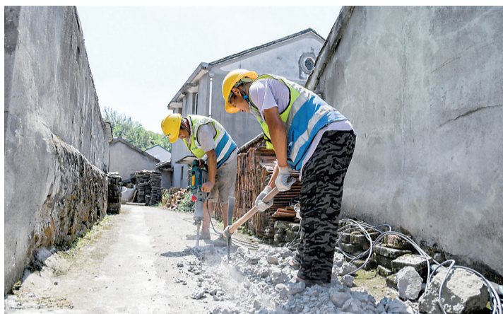
施工人员顶着烈日铺设水管。 通讯员供图
