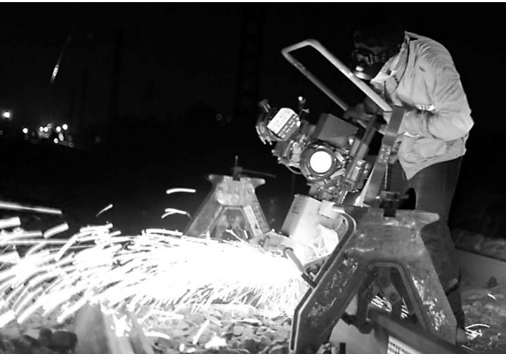
焊接钢轨 王威 李兴旭 摄
