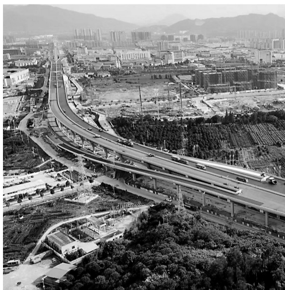
机场快速路南延建设场景
