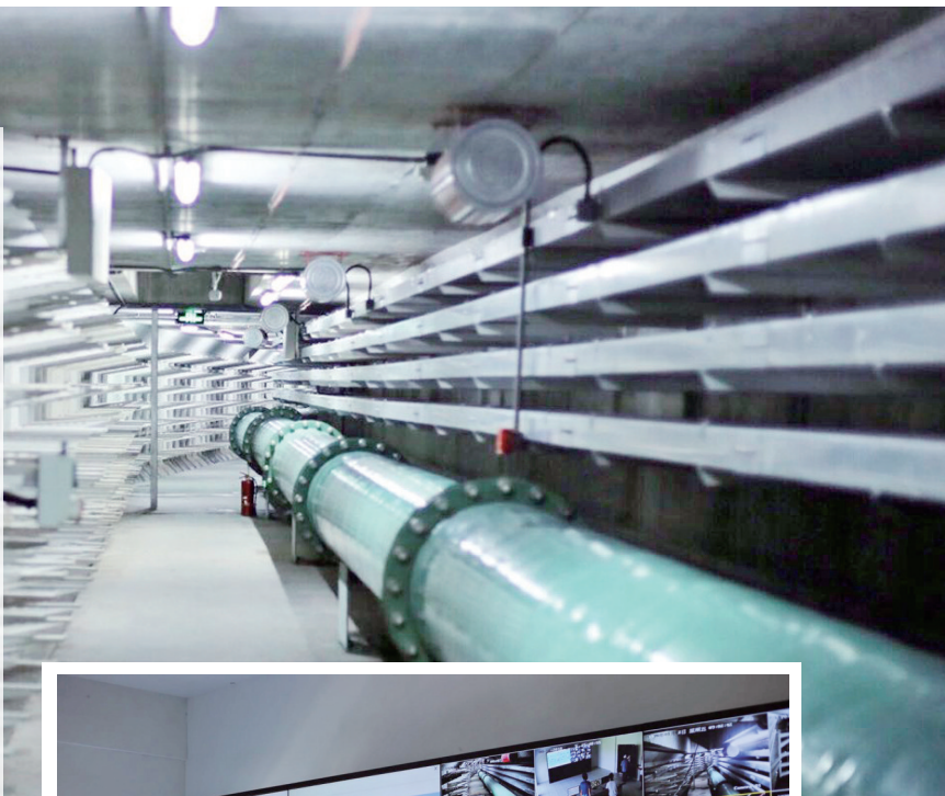
▲地下综合管廊。 ▲地下管廊设备监控系统。
