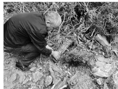
小区居民觉得野蛮施工很不应该。
