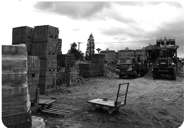
拆迁中的工地
