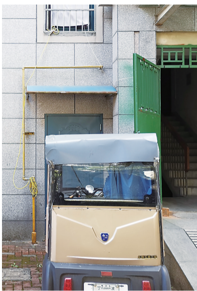
楼道口的电动三轮车以及从二楼垂下的电线。
