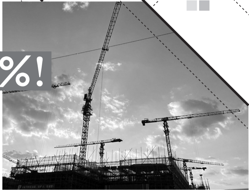
东部新城某楼盘施工工地。通讯员供图
