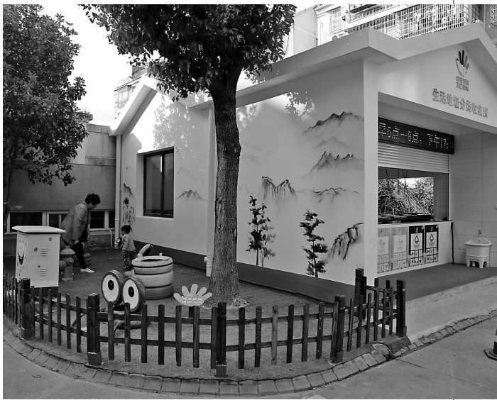
美好家园小区垃圾房外景。通讯员供图
