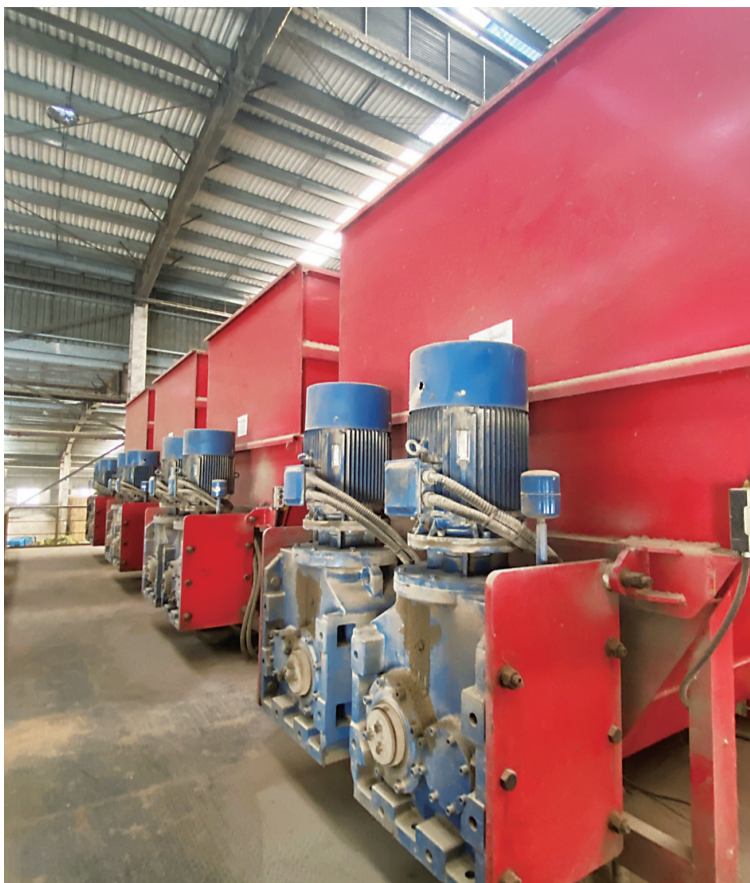
宁波宁兴涌优饲料有限公司生产车间。
