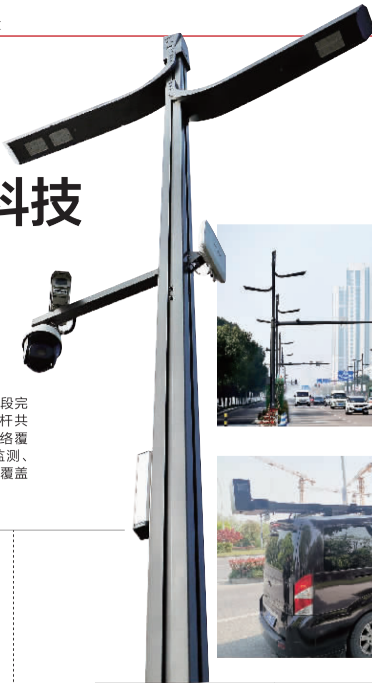
首南中路上的智慧灯杆
