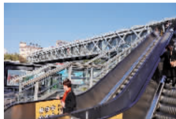
妇儿医院天桥电梯
