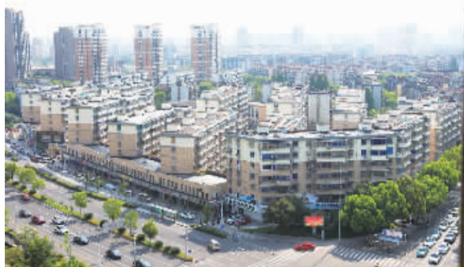
改造后的鄞州区民安小区。鄞州区住建局供图
