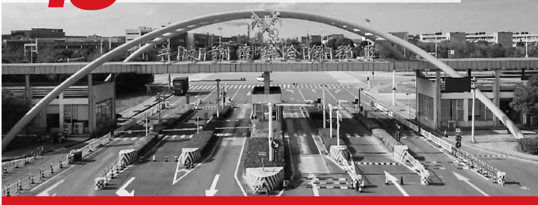
宁波前湾综合保税区通过现场封关验收。 通讯员供图
