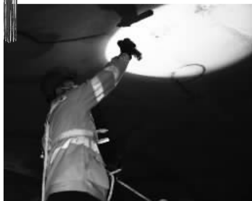
工人正在检查和喷漆。通讯员供图
