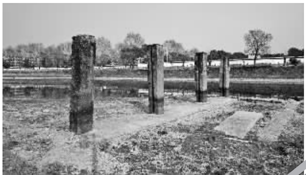
回沙闸遗存,左起第二根石柱为“则水尺”。
