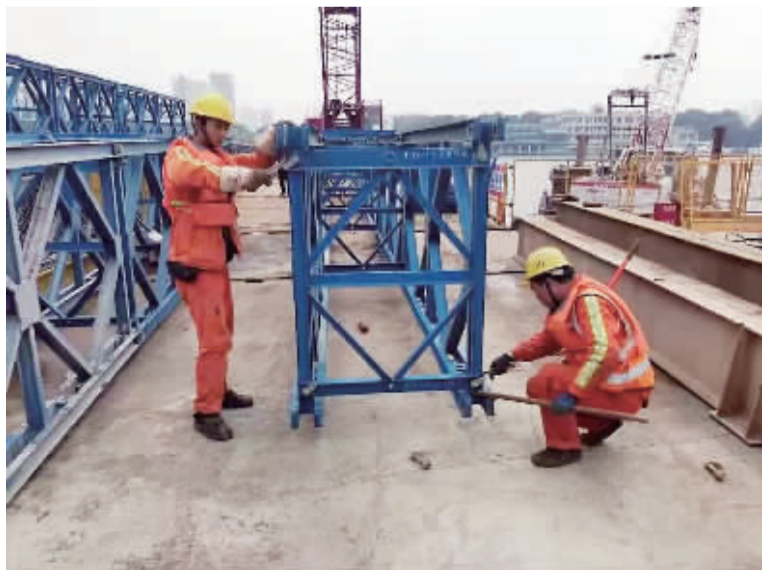
昨日上午,新典桥施工现场。通讯员供图
