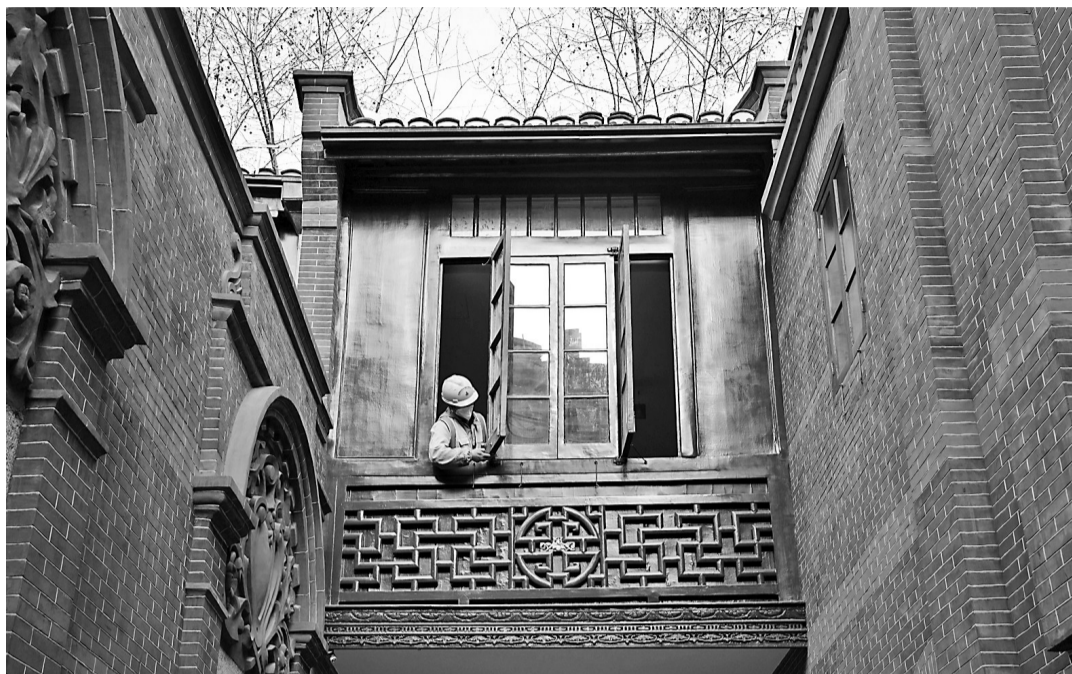
位于上海兴业路76号的中共一大会址自2020年11月17日起暂停对外开放,实施修缮改造,目前工程已进入收尾阶段。 新华社发
